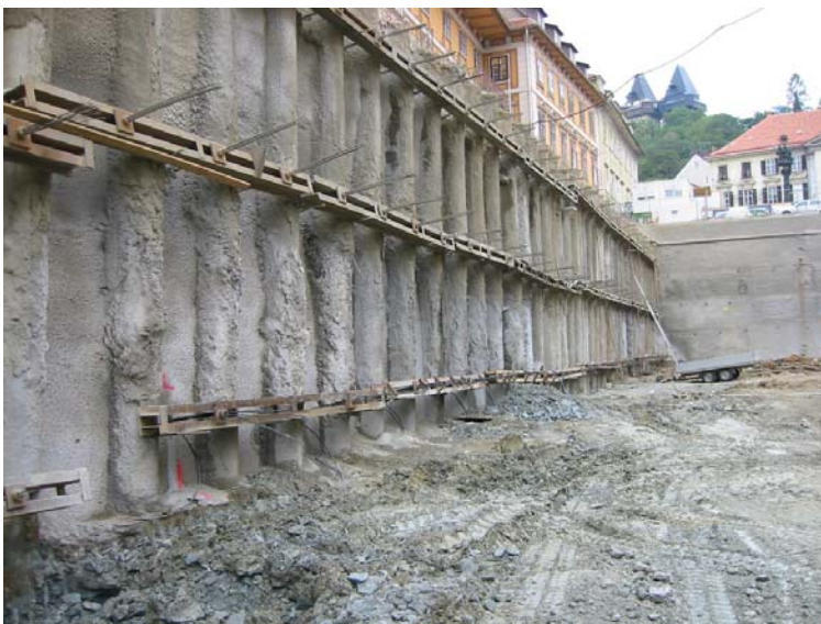
Baugrubenansicht Südrand – aufgelöste Bohrpfehlwand
