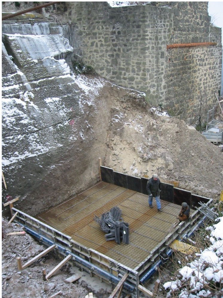
Maschinenraum Bergstation – Fundamentherstellung auf Bauschutt und Fels
