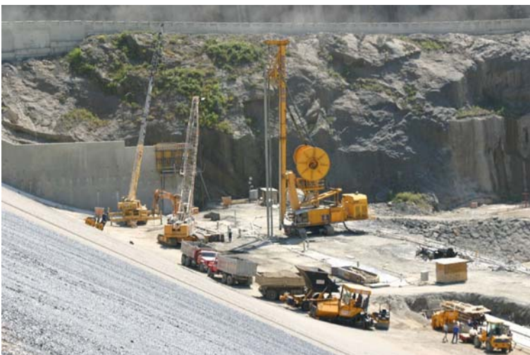
Schlitzwandherstellung im Mehrphasenverfahren (rechts: Schlitzwandfräse; Mitte: Schlitzwandgreifer)
