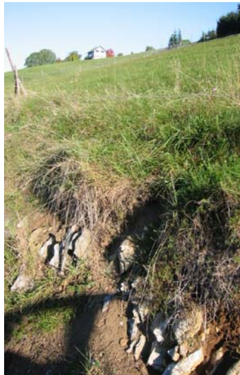
Harter Fels direkt unter der Wiese. Hier wurde aus Kostengründen auf den Keller verzichtet.
