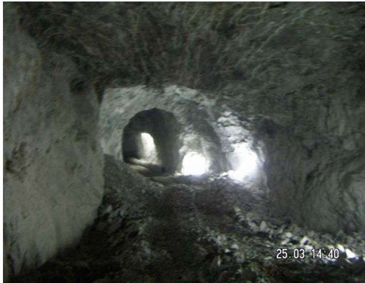
Teilverfüllte Abbaukammer des ehemaligen Anhydritbergbaues
