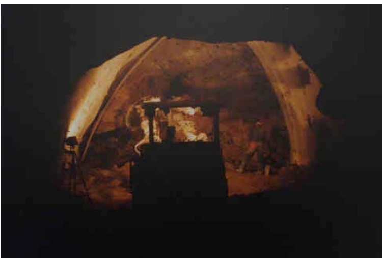
Vortrieb des westlichen Ulmenstollens
