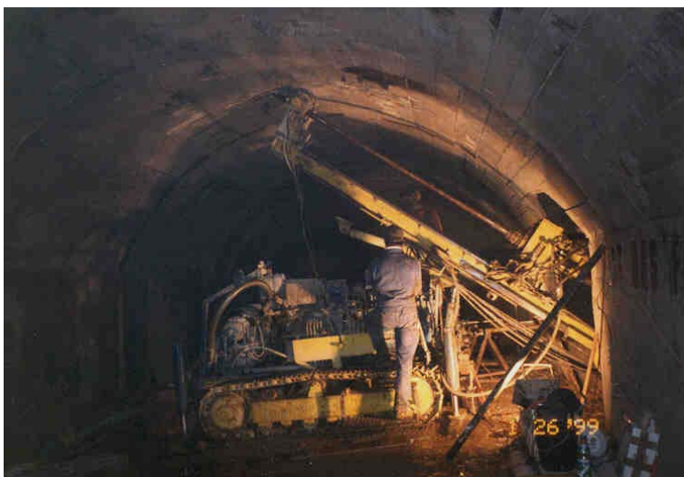
Kernbohrung aus einem bestehenden Stollen
