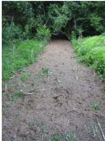
Spuren eines Schlammstromes, hervorgerufen durch überlastete Sickeranlage
