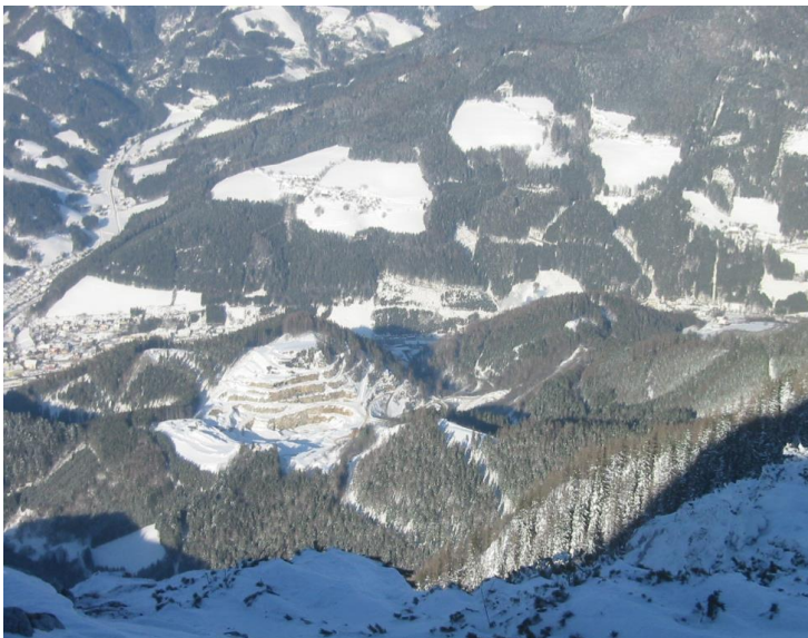
Magnesitbergbau Breitenau – Tagbau; Blick vom Hochlantsch nach Norden
