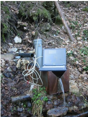
Abflussmessstation mit Datensammler
